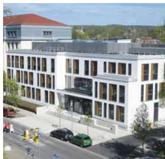
③① NCT/UCC Portalgebäude und UCC Forschungsgebäude
